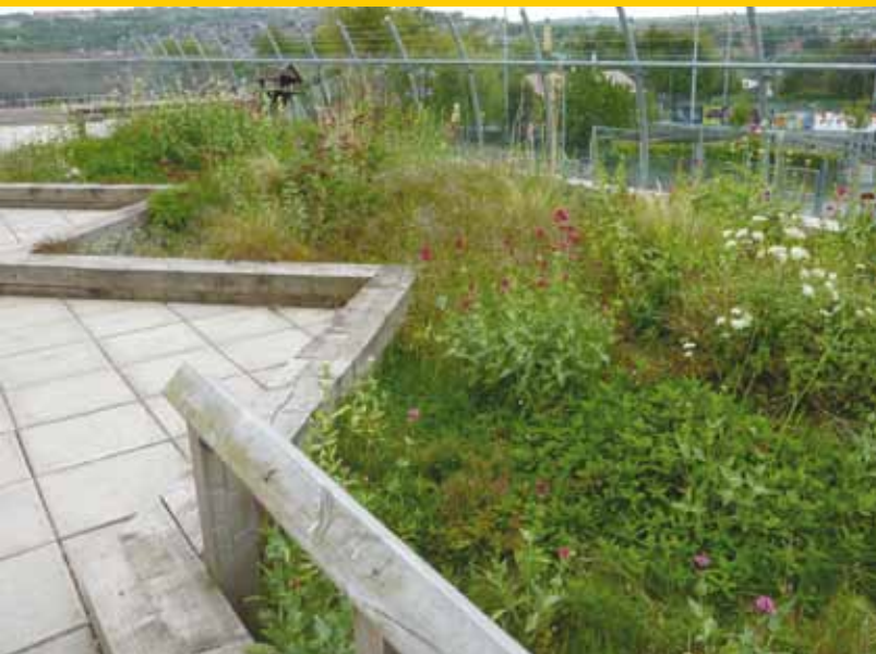
Overzicht van de vegetatie op het dak van de school.
